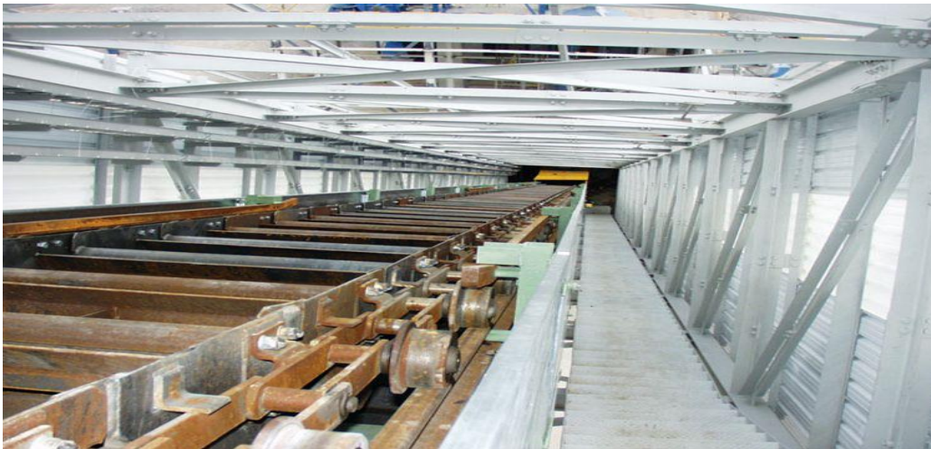
Figure 0-5 TTP - Deep bucket conveyors [5]
